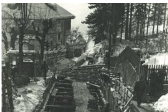
Verlegung der Ringrohrleitung in der Josef Schraffl Straße.
